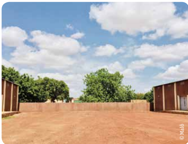
Entrepôts de Faso Jigi. La chaîne de fortification du riz de Malo est installée dans le bâtiment de gauche ; le riz non fortifié est stocké dans le bâtiment de droite (Ségou, Mali).
